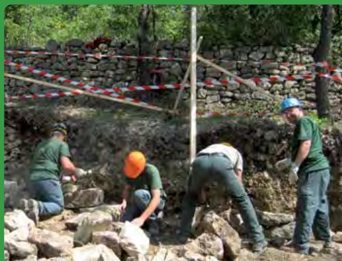
LES RANDO-PISTEURS DU DÉPARTEMENT RÉALISENT UN MUR EN PIERRES SÈCHES SUR UN SENTIER DE L'HÉRAULT
